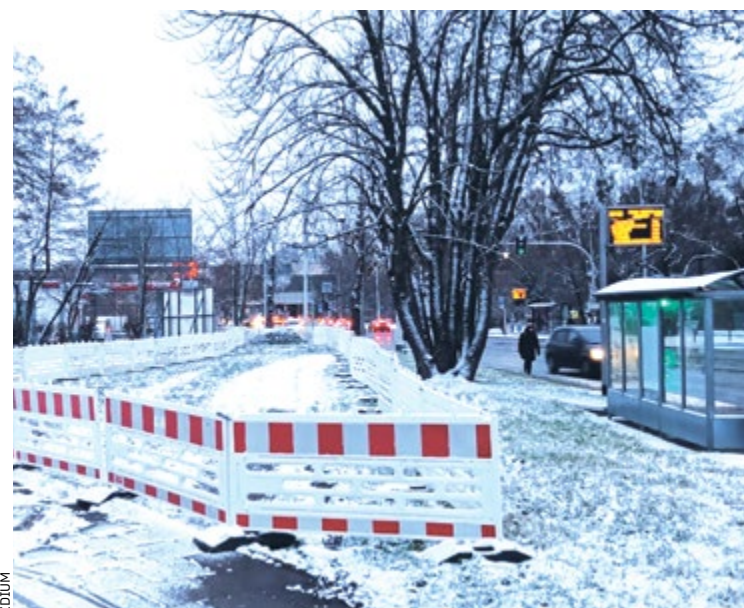
Prace przy budowie przystanków nie powodują ograniczeń w ruchu
